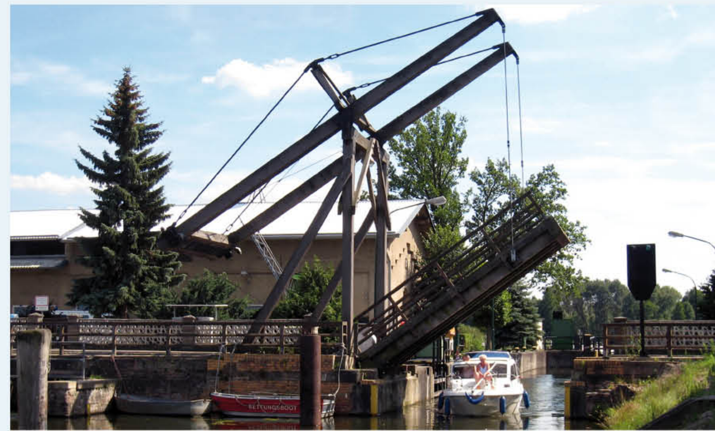
Neuhauser Speisekanal (NSK), Schleuse und Klappbrücke Neuhaus
