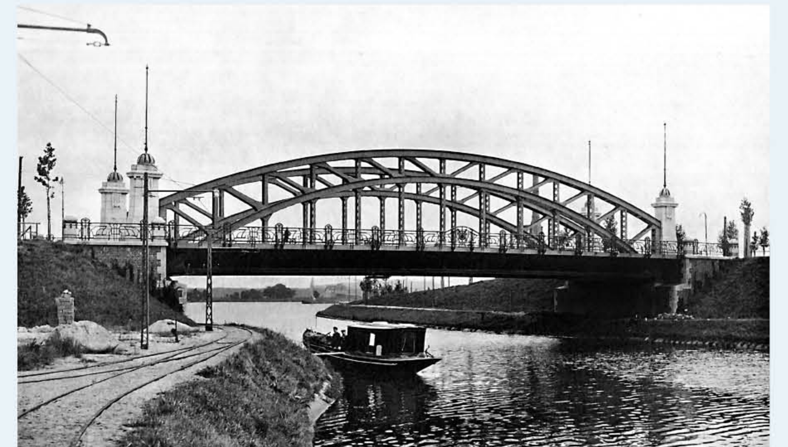
Brücke der Chaussee Köpenick-Grünau, links die Trasse für die Treidelokomotive
