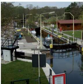
Schleuse Storkow, Schleuse Wendisch Rietz
