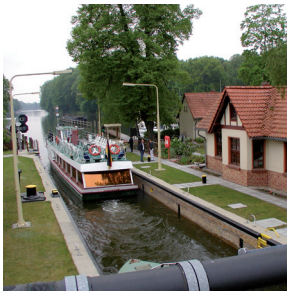
Schleuse Kummersdorf, Schleuse Neue Mühle
