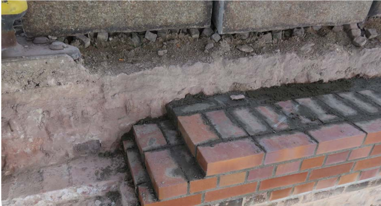
Erneuerung des Mauerwerkes
