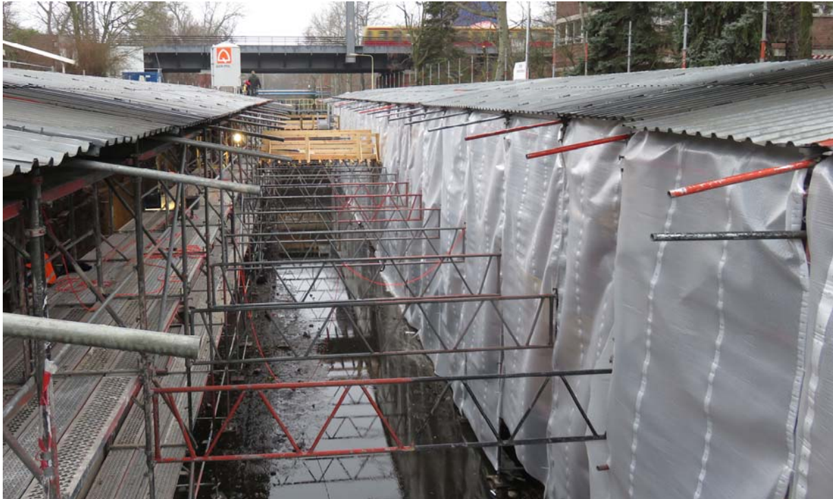
Einhausung der Schleuse im Winterzeitraum
