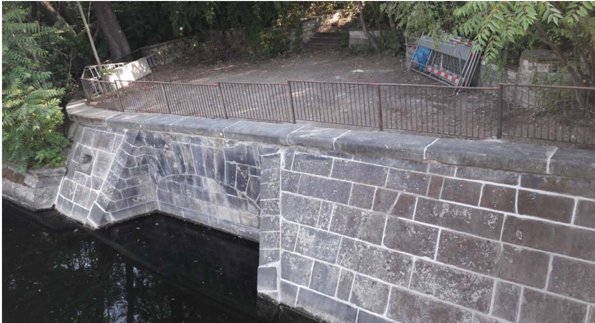
Schöneberger Brücke rechtes Ufer unterhalb
