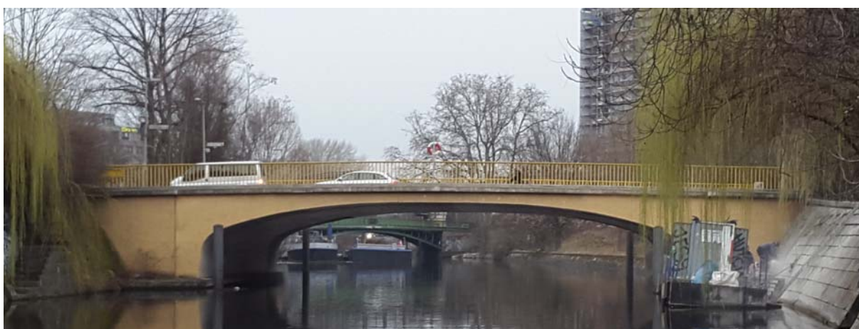
Fugenpflege km 4,820 – 5,240 beidseitig
